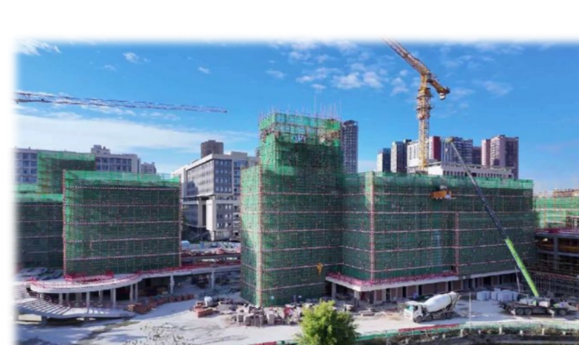
建设中的广西大学土木工程综合实验中心。黄海珠/摄
