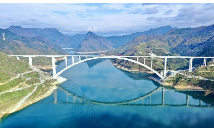
1 郑皆连院士团队主持建造的世界最大跨径混凝土拱桥——天峨龙滩特大桥。（广西路桥工程集团有限公司供图）
