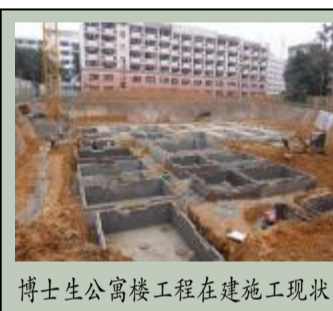
博士生公寓楼工程在建施工现状
